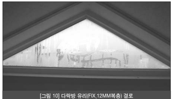
[그림 10] 다락방 유리(FIX,12MM복층) 결로
