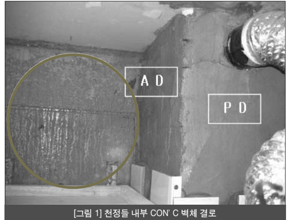
[그림 1] 천정틀 내부 CON C 벽체 결로
